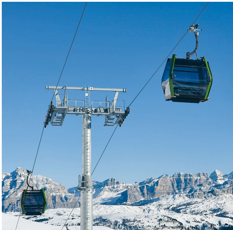
Le cabine del nuovo impianto.
